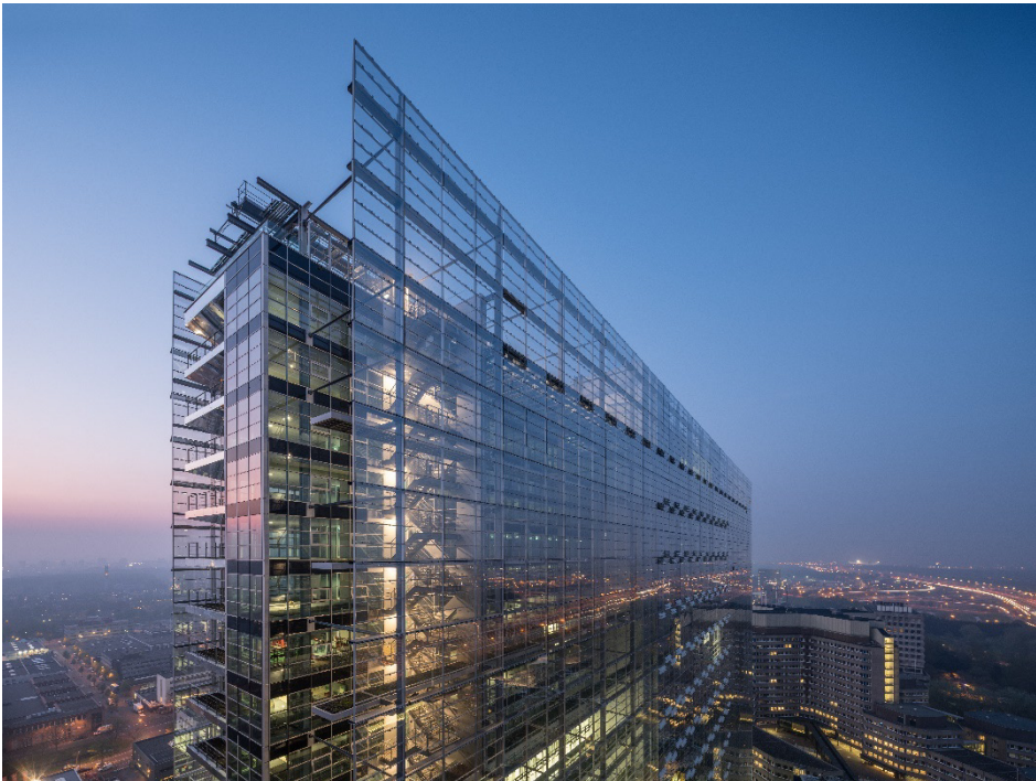
Figure 15 – OEB La Haye, nouveau bâtiment principal
