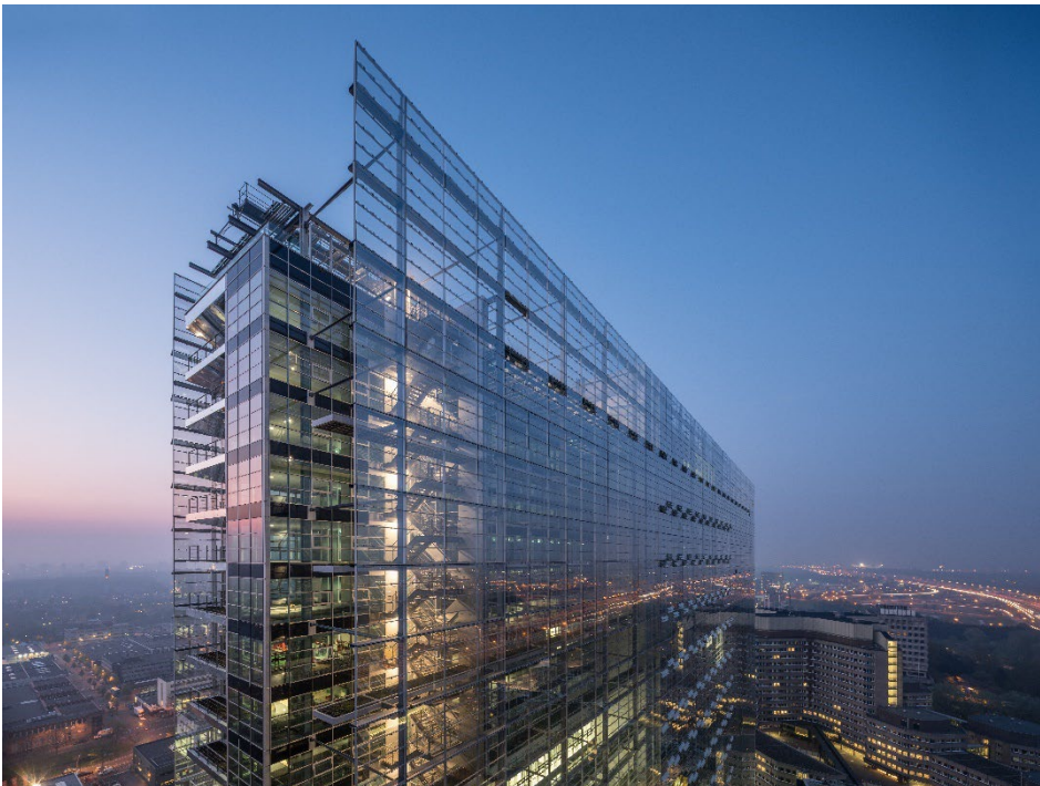
Abbildung 19 – EPA Den Haag, New Main
